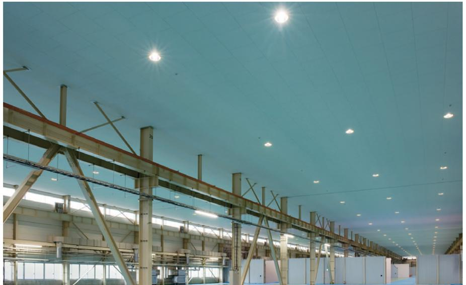
製造室内部 窓側(左)と通路側とに区分した2系統の配線に計132台を整齐配置して、室内照度を約500lxに維持する
