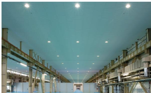
製造室内部 天井高さ10mの高天井空間から光が降り注ぐ高効率HID照明
