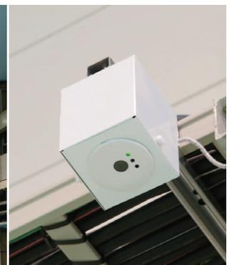
あかりセンサ 床上4mの位置で床面の反射光を感知する設定
