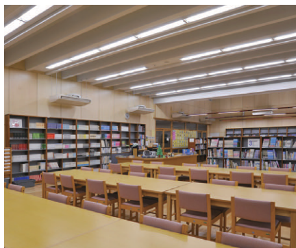
図書室の照明 Hf32W1灯用直付調光器具を連続配置。廊下・談話コーナーの照明 談話コーナーは天井木製ルーバ内に照度センサとの連動で適正照度を維持し省エネ
