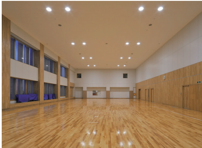
武道場の照明 ネオセラ250W強化ガラス付ダウンライト (50~100%調光)を採用。照度センサにより300lxを維持しつつ適正照度制御で省エネ
