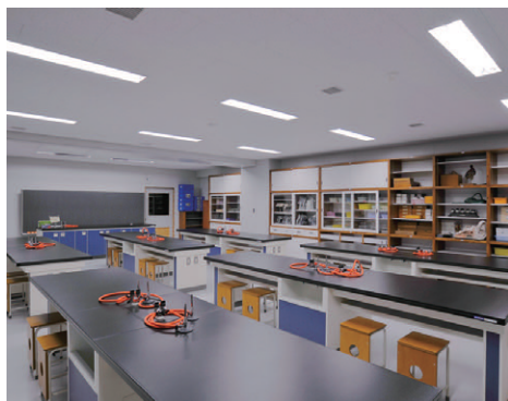
理科室の照明 Hf32W2灯用スクールソフト埋込調光器具と照度センサとの連動制御による適正照度で目の負担を軽減
