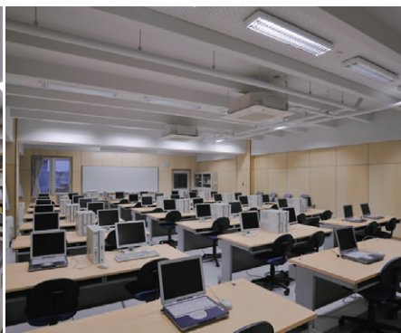
コンピュータ室の照明 Hf32W2灯用OALルーバ付直付調光器具を均等配置、照度センサにより適正照度制御
