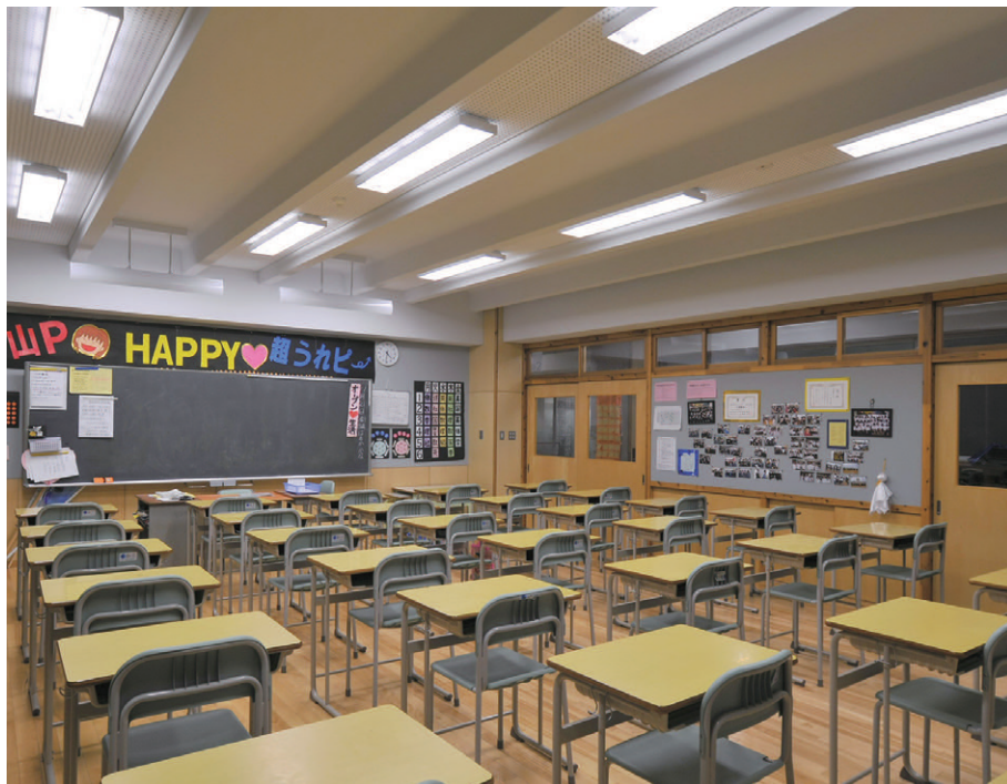
普通教室の照明 Hf32W2灯用スクールソフト直付調光器具を採用し、初期照度補正・昼光利用制御により省エネ
