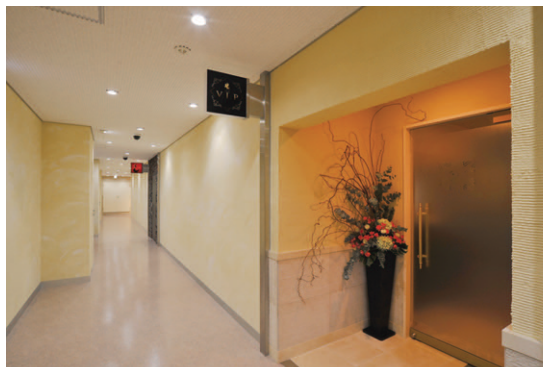
店舗前の廊下の照明 E-CORE〔イー・コア〕LEDダウンライト400クラスの千鳥配置で高い均斉度を確保
