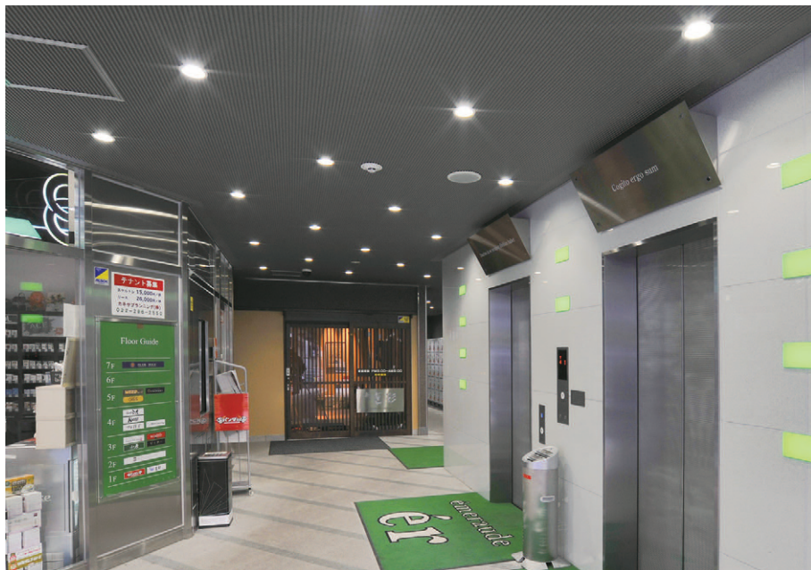
1階エレベータホールの照明 E-CORE〔イー・コア〕LEDダウンライト400クラスを千鳥配置で設置
