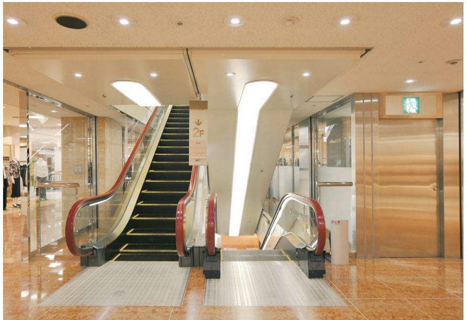
エスカレータ昇降口周りに設けられた[E-CORE]LEDダウンライト300クラス。熱のこもりを解消しつつ、省エネを実現
