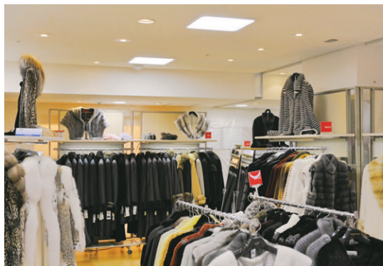
ファッション売場の演出用照明としてE-CORE[E-CORE]LEDダウンライト300クラスに更新
