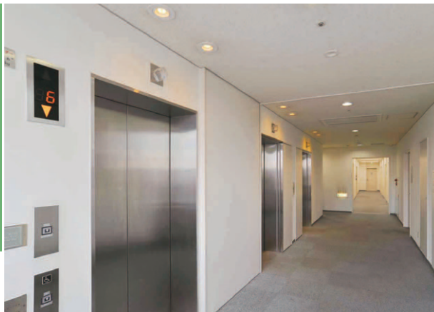
2階エレベータホール 更新されたE-CORE〔イー・コア〕LEDダウンライト400クラス
