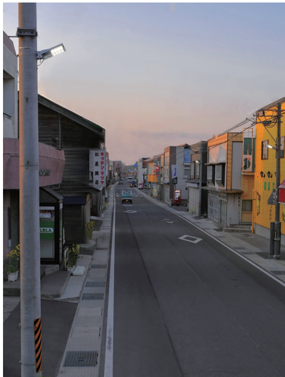
上り方向を望む横浜町商店街通り それぞれの電柱・ポールの地上4.5m上にLED防犯灯を設置
