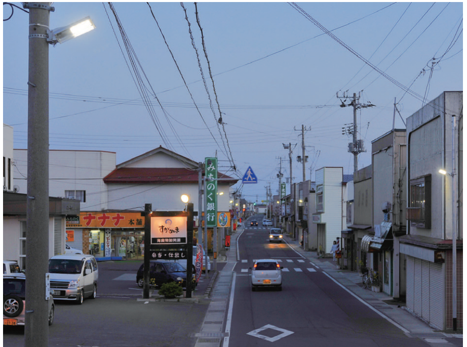
下り方向を望む横浜町商店街通り LED防犯灯を千鳥配置の電柱・ポールに設置
