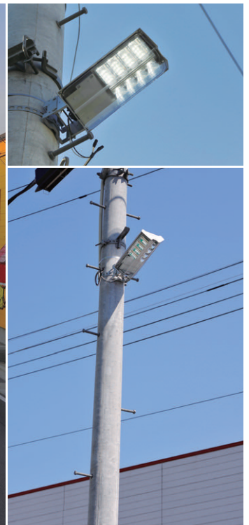
電柱に設置された〔イー・コア〕LED防犯灯（LED40VA用）
