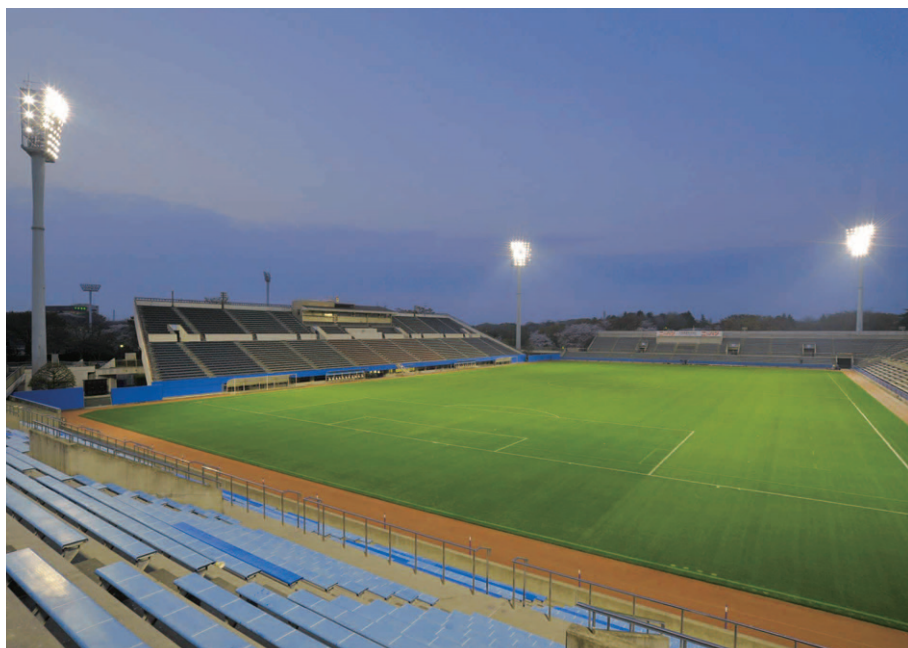
照明リニューアルされた球技場のナイター設備
