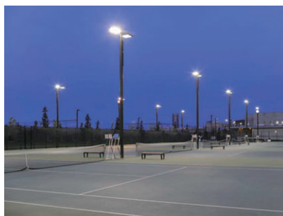
テニスコート内の照明 コート間には2灯用のテニスコート専用器具を、ベースライン後方には1灯用テニスコート専用器具を配置
