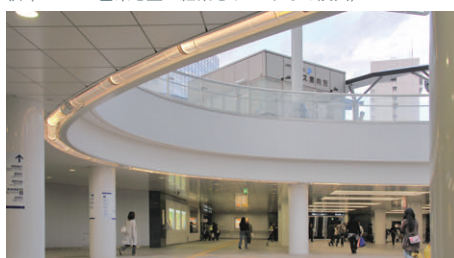
地下広場開口部エッジに設けられたライトパイプ
