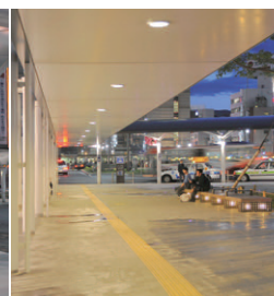
連絡シェルターのコンパクト形蛍光ランプ42Wダウンライト
