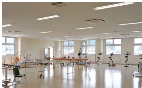
リハビリテーションセンターの照明 FHF32W×2灯用薄形直付器具を均等配置
