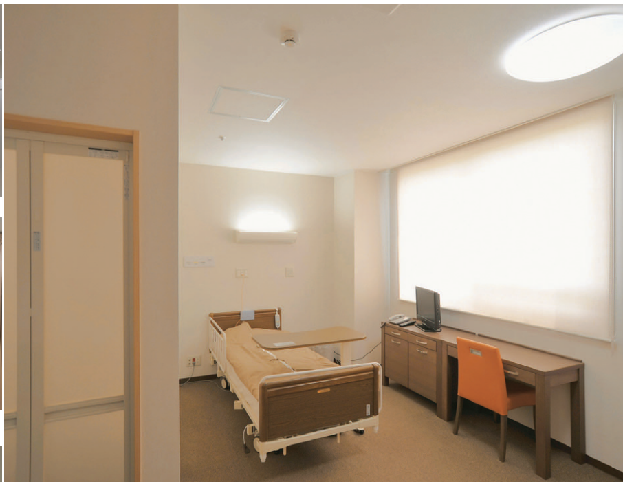
病室の照明 ベースには丸形のシーリングライト、ベッド灯は間接照明・読書灯・常夜灯一体形タイプを採用
