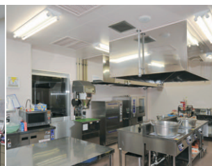
調理室の照明 FHF32W2灯用逆富士形防湿タイプを設置
