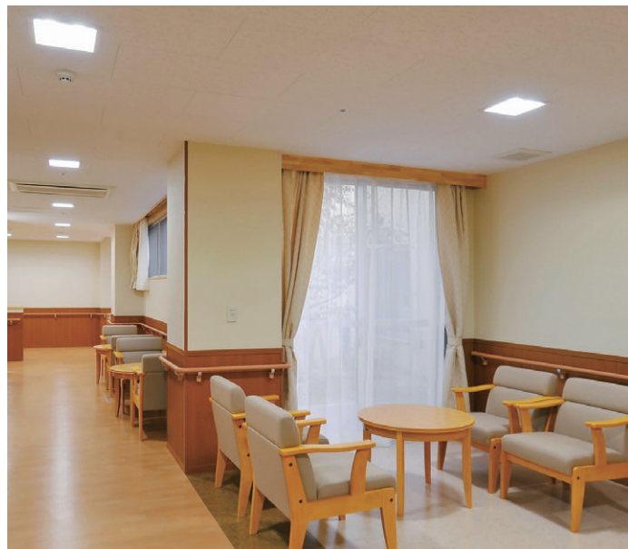
談話コーナーの照明 FHT32W2灯用埋込スクエア器具ルーバ付を使用
