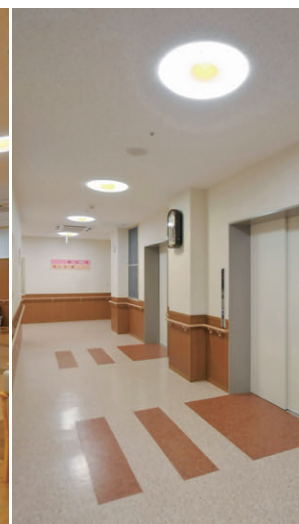
エレベーターホールの照明 丸形デザイン器具セルーチェを採用
