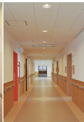
2F廊下の照明 間引点灯が可能
