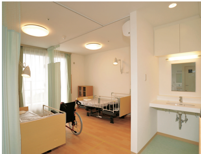
居室(2床)の照明 家庭的な親しみのある丸形シーリングライトをベース照明に、洗面台にミラーライトを採用
