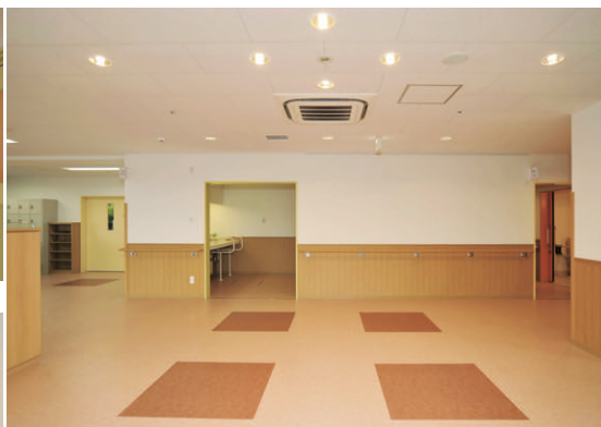
エントランスホールの照明 反射率のよい銀色鏡面のダウンライトを採用
