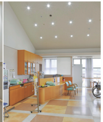
食堂の照明 LEDダウンライトに更新し、省エネと明るさを確保しつつ、器具の存在感を抑制
