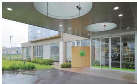
軒下にはLEDダウンライト軒下用を採用し、ランプの省メンテナンスと虫の集まりを抑制
