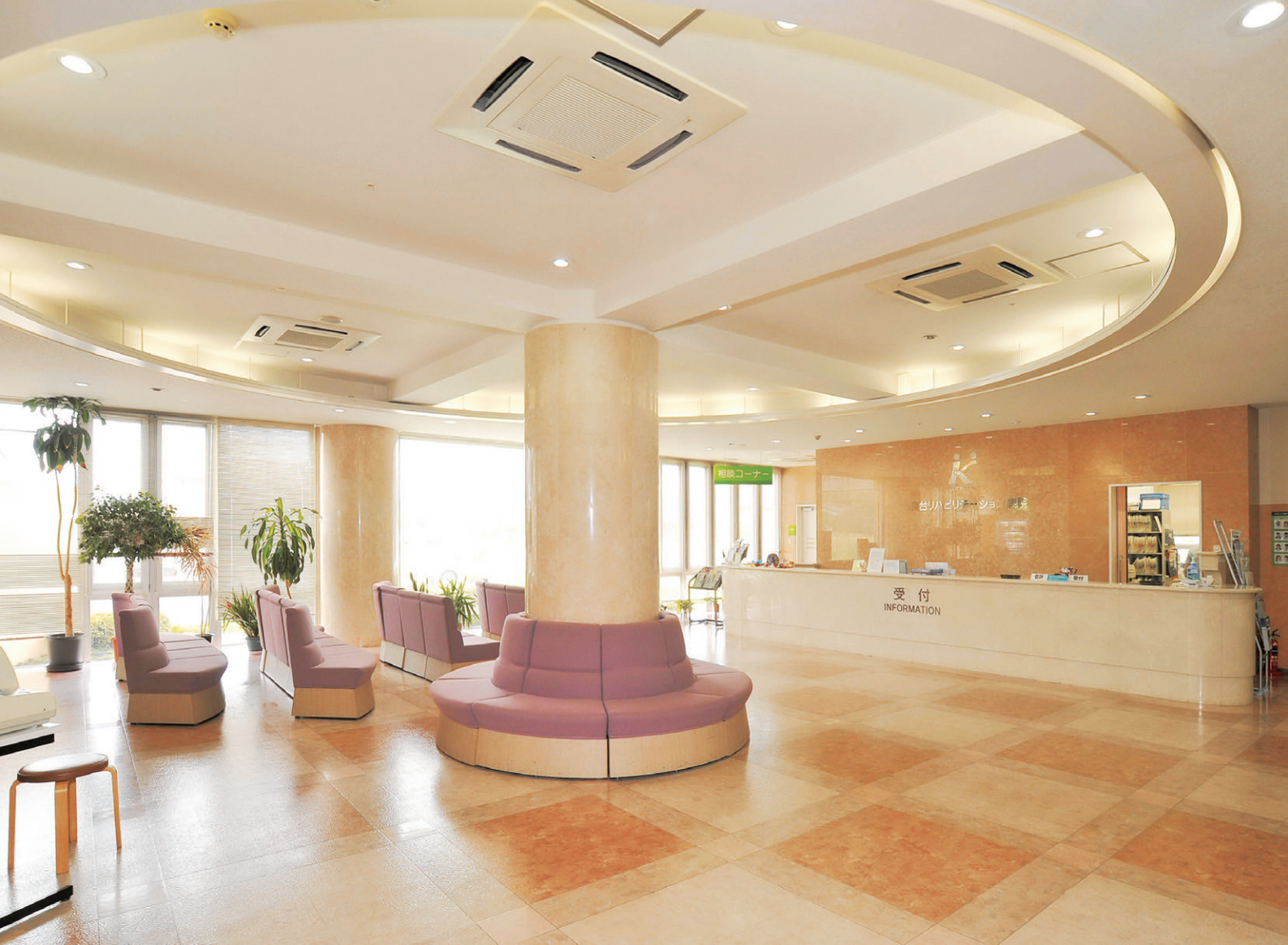
エントランスホールの照明 27Wコンパクト形蛍光灯ダウンライトからLEDダウンライト〔イー・コア〕500シリーズに更新。従来と同等以上の明るさを確保しつつ、省エネを実現
