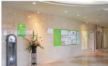
LEDダウンライトを採用の玄関ホール周りの照明
