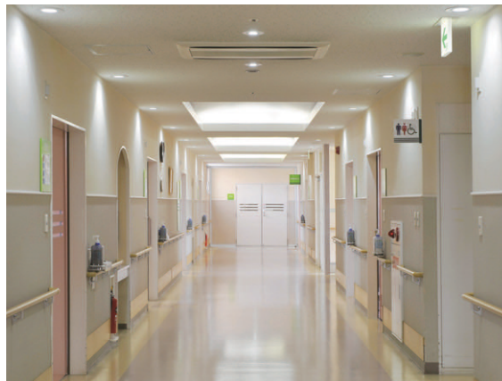
廊下の照明 小電力のLEDダウンライト〔イー・コア〕により24時間点灯でも低維持費
