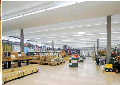
資材館の照明 FHF86W2灯用笠なし器具をレースウェイに床上5.5m高さにて設置
