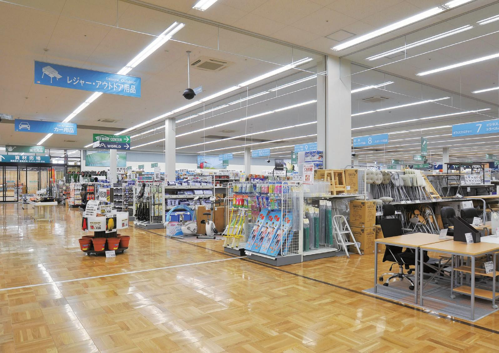
園芸館よりオフィス・レジャー用品売場方向を望む FHF86W2灯用薄形直付器具により、顧客の混み具合に応じて時間帯別の調光によるエリア別タイムスケジュール制御で効果的に照明しながら省エネ
