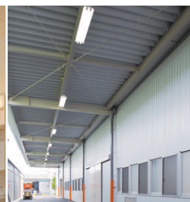
軒下に設置されたFHF32W×2反射笠器具防湿防雨形
