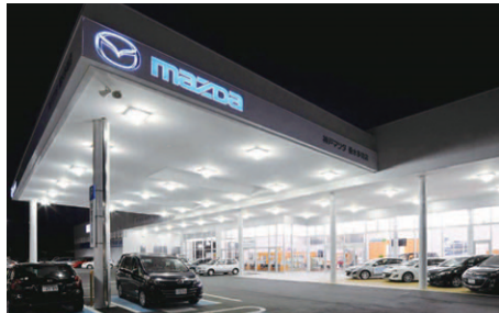
高く広いキャノピーの照明 前面ガラスに光触媒グローブ採用のサービスステーション用器具を使用し、清掃作業を軽減
