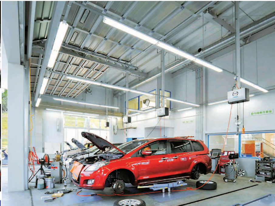
整備中の車が眺められるサービス工場の照明 精密作業を考慮してHf32W2灯用反射笠器具を口の字配置
