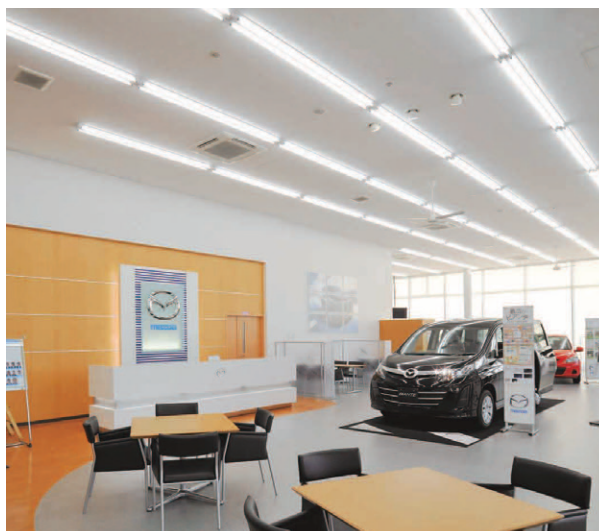
受付正面からショールーム方向を望む 明るい照明環境としつつ、点灯区分を細分化して天候に応じて無駄な明るさを抑制できるように配慮
