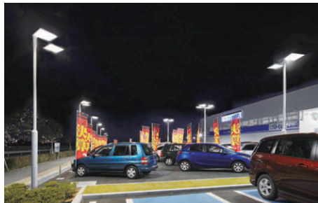
テニスコート用照明器具を採用した中古車展示場
