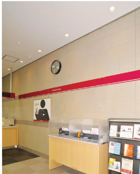
記帳コーナーの照明 LEDダウンライトを壁面に沿って設置
