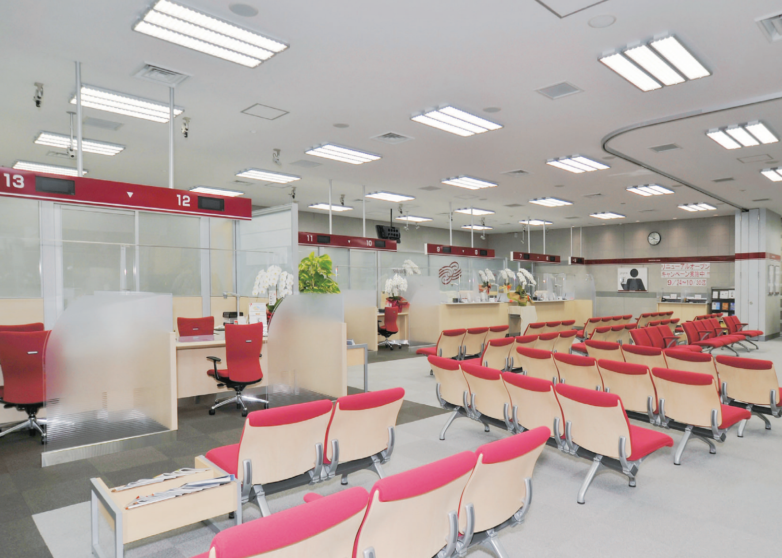
広く改修されたロビーの照明 LEDベースライトストリートタイプを3台並列に組み合わせ、均等に配置。明るさは更新前より明るい1000lx
