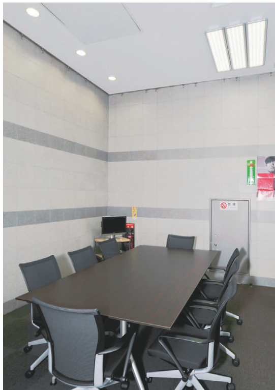
LEDベースライトストレートタイプとLEDダウンライトを設置した応接室
