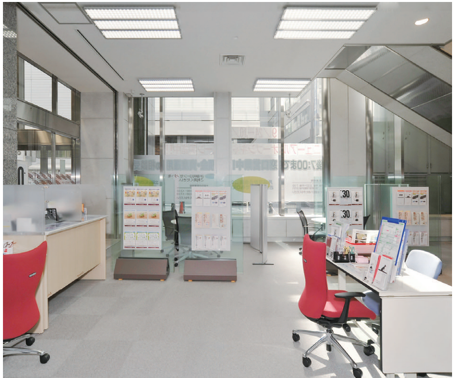
相談コーナーの照明 LEDベースライトストレートタイプ3台組み合わせとLEDダウンライトを使用
