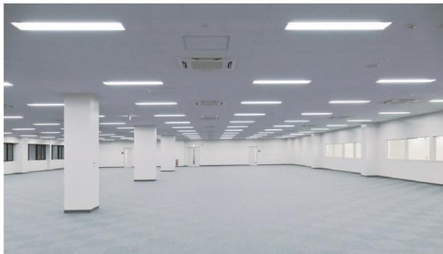
事務室エリアの照明 照明器具個別制御システム「T/Flecs」のFHF32W2灯用通信機能付埋込器具を使用
