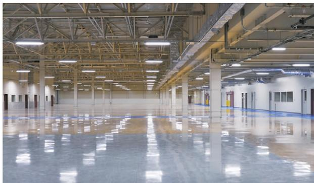
FHP105W2灯用通信機能付反射笠器具による照明器具個別制御システム「T/Flecs」の入出荷場エリアの照明
