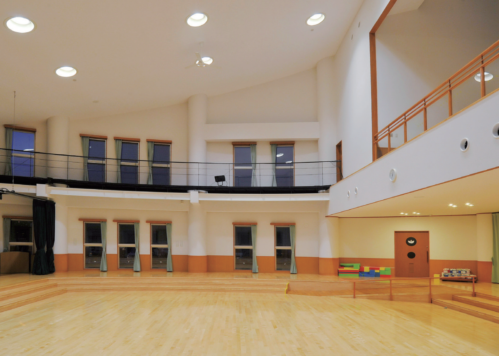
広い吹抜空間とした遊戯室の照明 高効率の250Wネオセラダウナイト（電動昇降装置付）を均等配置。省エネを図りながら快適な明るさを確保
