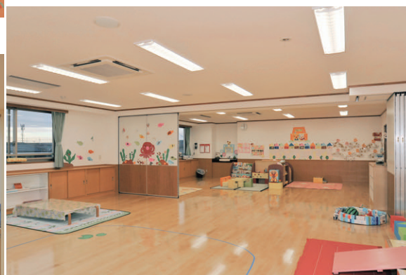
子育て支援室の照明 32WHf蛍光灯ランプ2灯用バツフル付埋込器具を均等配置
