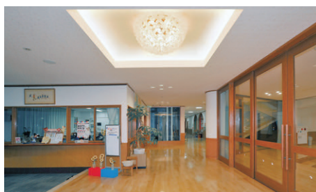
シャンデリアを中央にしてその周囲に間接照明を配した玄関・エントランスの照明
