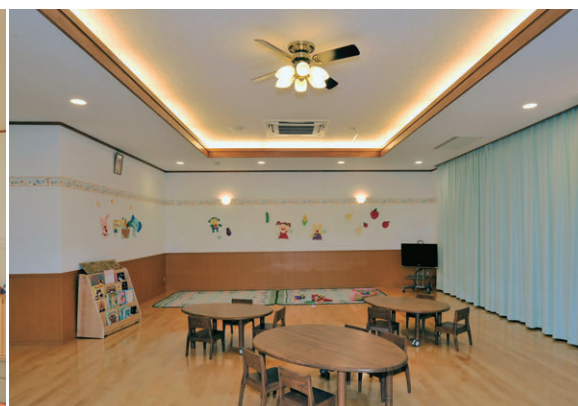
ランチルームの照明 折上げ天井を柔らかな光の間接照明とし、その中央にファン用シャンデリアを設置
