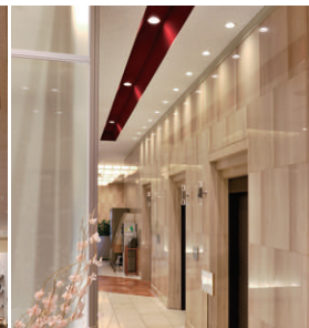
天井埋込照明とコーニス照明を組み合わせたエレベータホール
