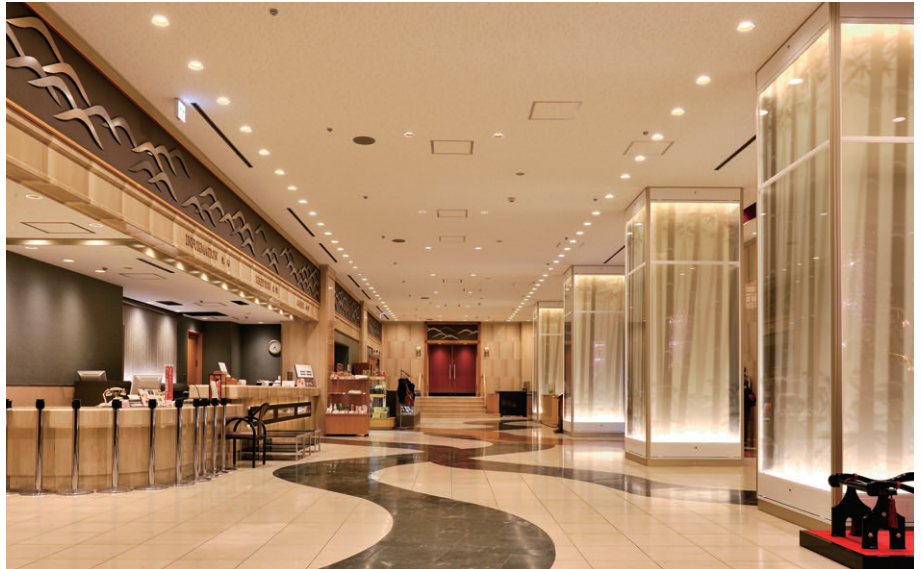
リニューアルでオールLED化されたホテル1階フロント、ロビーの天井照明
