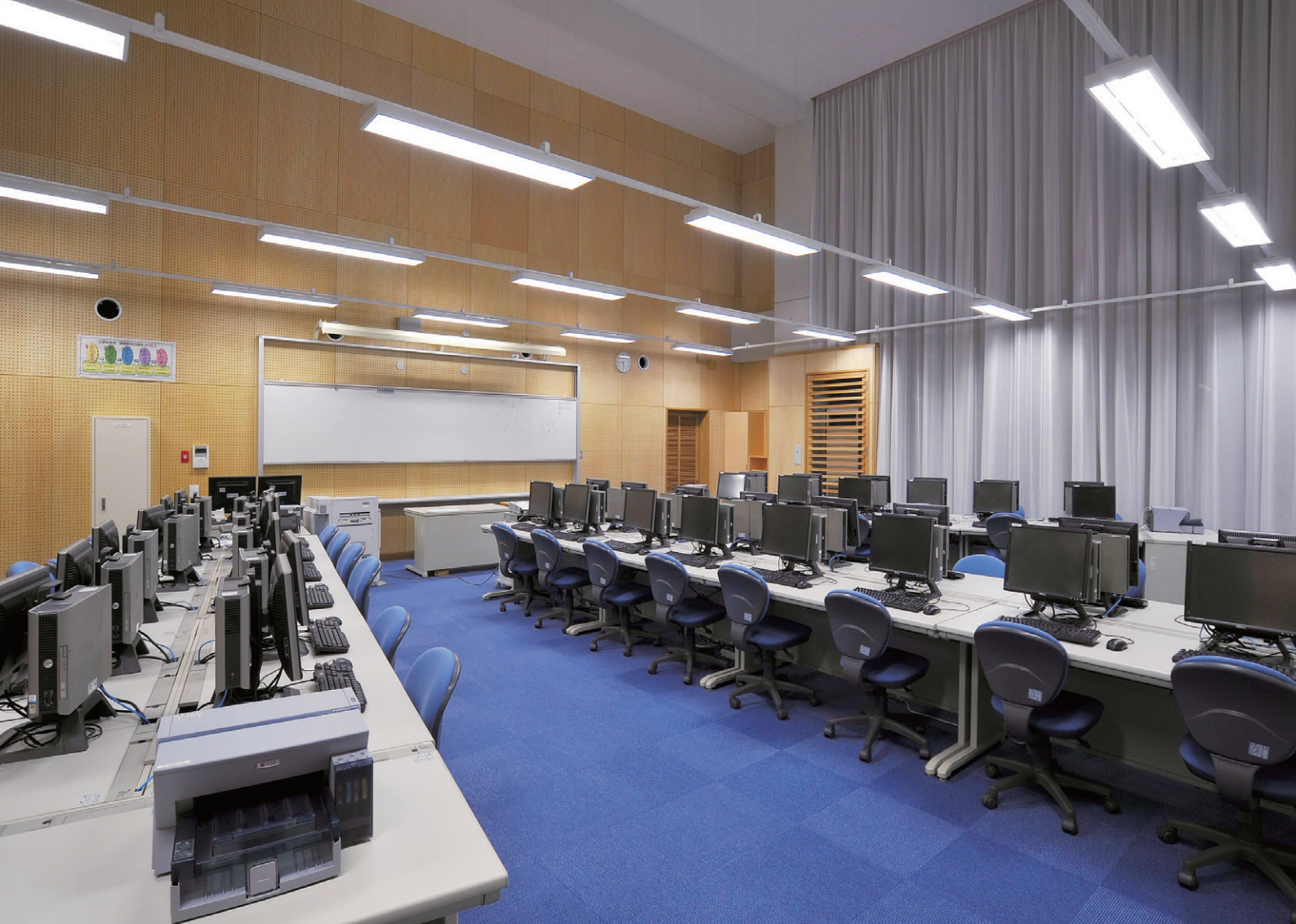
パソコン教室の照明 教室専用器具スクールソフト直付形をレースウェイに均等配置。学習空間全体を包み込んだ光で長時間の学習でも対応可能な環境を創出
