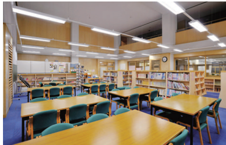
パソコン教室と一体の空間となっている図書室の照明
