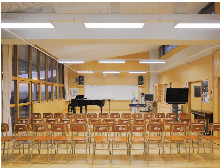
音楽室の照明 適正グレア制御の教室専用器具スクールソフトを採用し、目に優しい明かりを得ながら適正照度を確保
