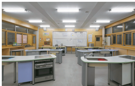
調理・家庭教室の照明 水を利用するため、錆びにくく、耐食性に優れたステンレス防水器具を採用
