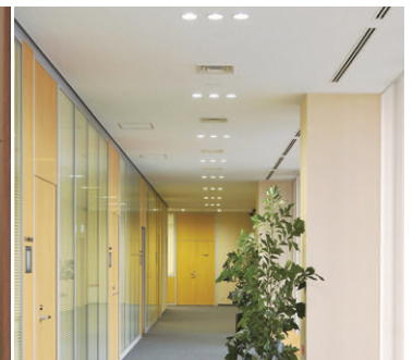
2階の研修室に隣接している廊下のLEDダウンライト照明
