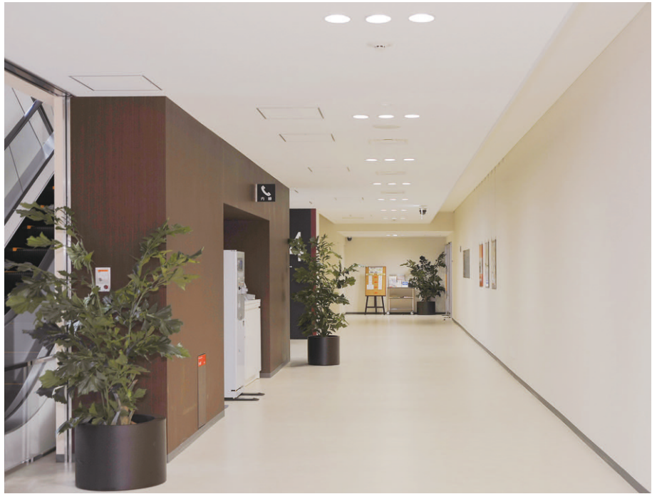
4階食堂廊下の照明 LEDダウンライト900シリーズ電球色相当を3台並べ3mピッチで配置
