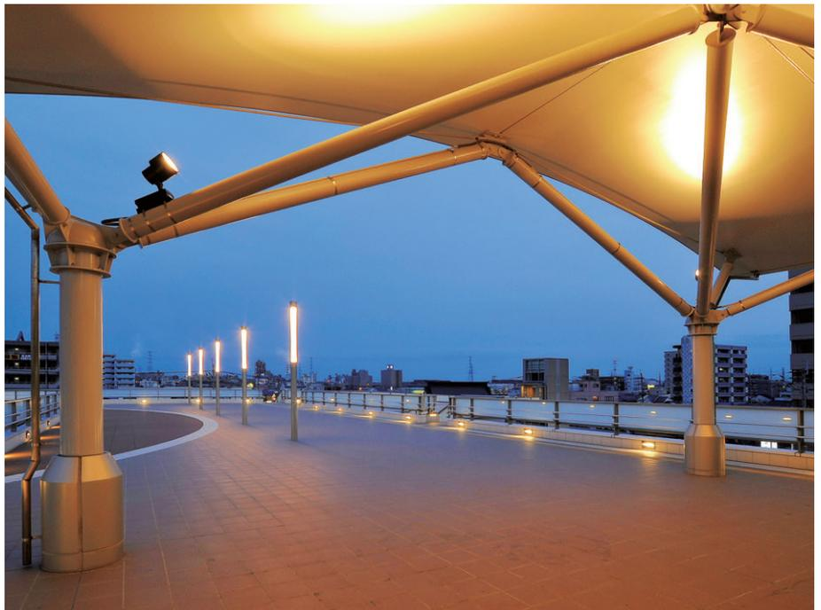
デッキ出入口部にかかるシェルターには投光器により天井へアップライト。デッキ中央にはポールタイプのアプローチライトを、高欄側にはフットライトを配置
