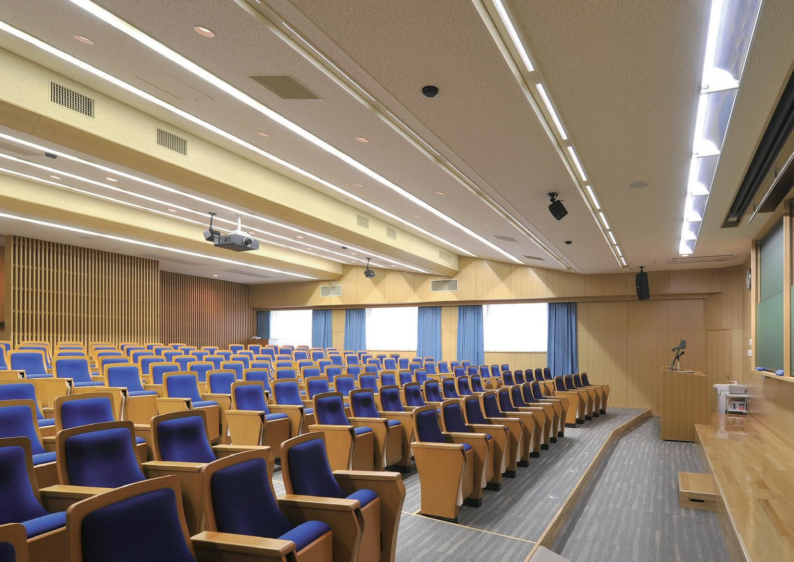
演台側から後方を望む大講演室の照明 スリットラインの照明ボックス内にLEDベースライトスリムストレートタイプ連結設置を採用。スリットライン間の天井にはLEDダウンライトを配置
