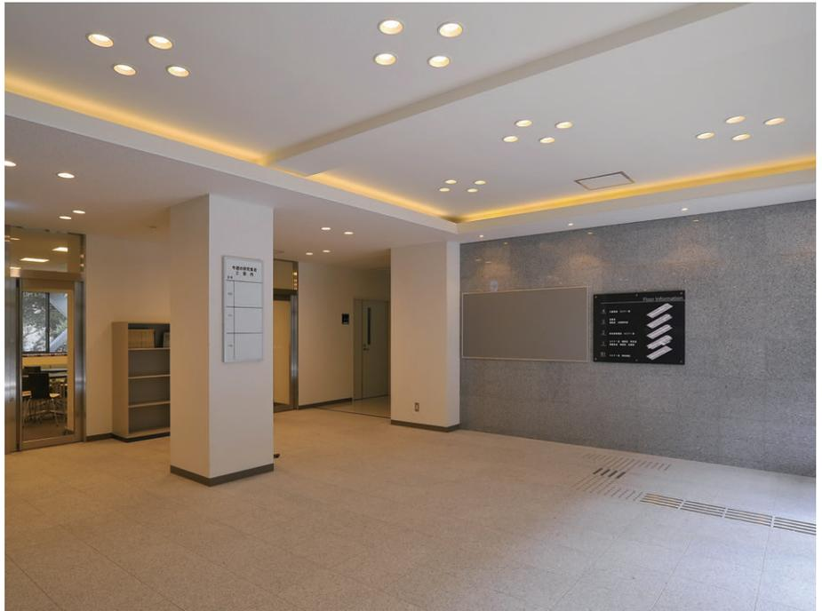
玄関ホールの照明 間接照明にLEDライン器具を、平天井にはLEDダウンライトを設置
