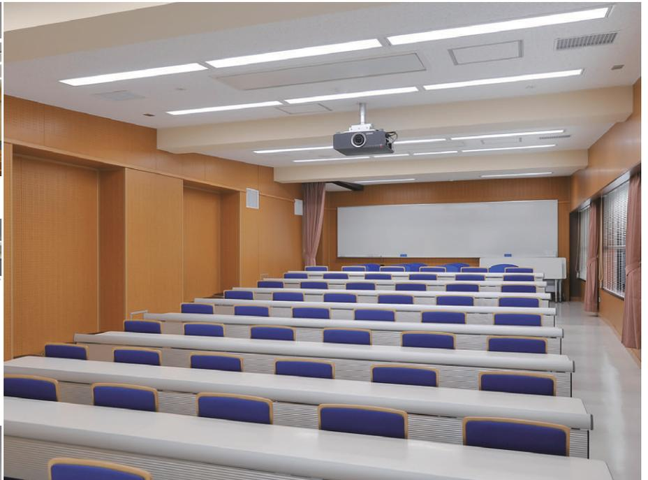
講義室の照明 FHF32W2灯用埋込器具(カバー付)調光形を採用。昼光利用制御で適切な明るさを確保しつつ、省エネ
