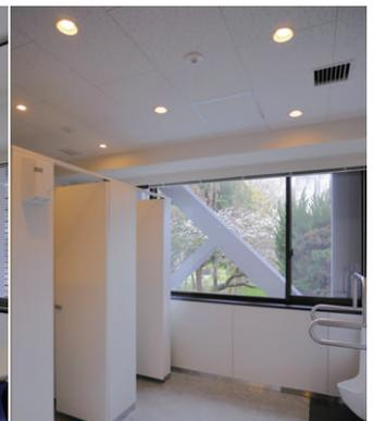
トイレの照明 LEDダウンライトと人感センサーにより自動ON・OFF制御
