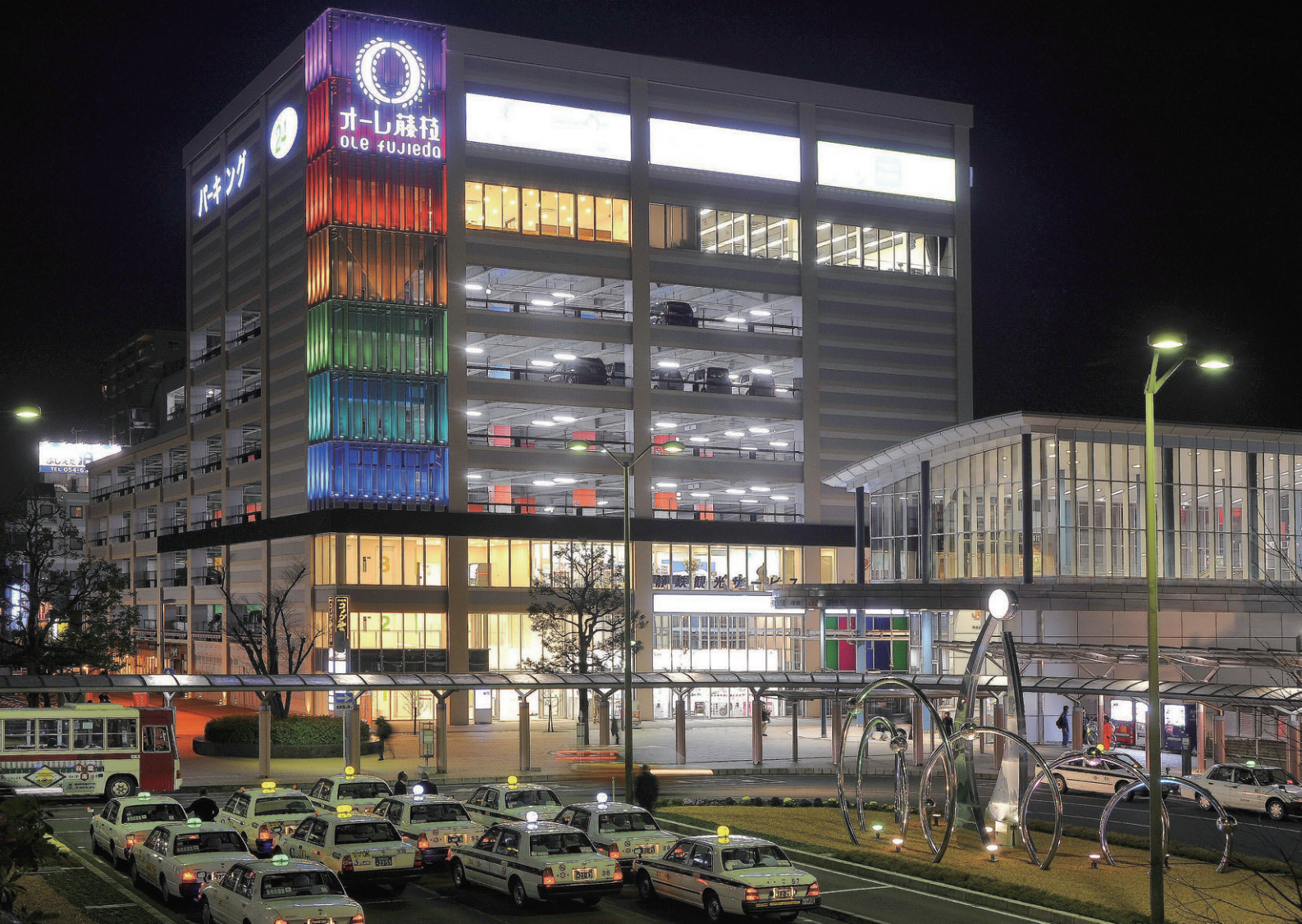
イベントや四季に応じてR・G・Bの3色のLEDにより、混色制御で演出パターンの色・変色スピードを設定した演出プログラムを自動再生し、壁面を鮮やかに演出
