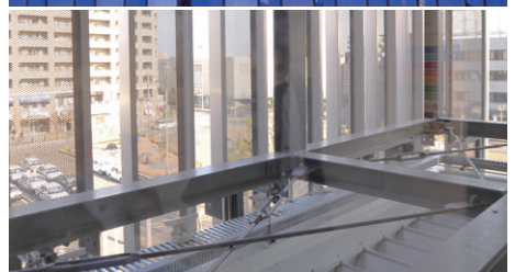
市松模様に配置した有孔ステンレスアルミ鋼板とその前方下部架台に設置したデジタルライト（カラープラスト）昼間の情景
