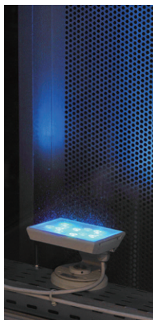
外壁に設置された有孔ステンレスアルミ鋼板を照射しているデジタルライト（カラープラスト）を建物内部から望む
