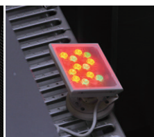
外壁に設置された有孔ステンレスアルミ鋼板を照射しているデジタルライト（カラープラスト）を建物内部から望む
