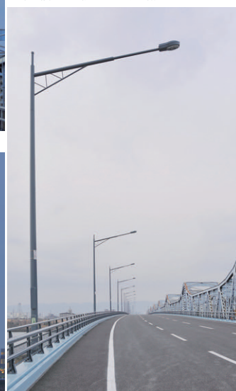
照明柱高さ10m、出幅4mアームに装着されたLED道路灯
