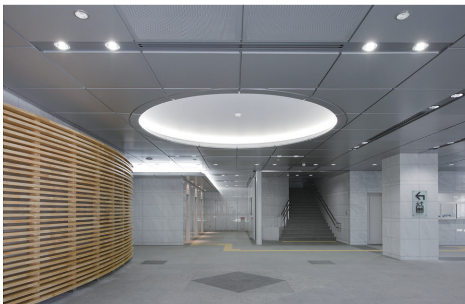
エントランスホールの照明 Hf蛍光灯ランプの間接照明とダウンライトを利用者の動線に合わせて効果的に配置
