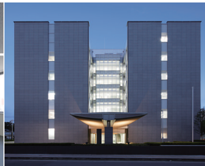
庁舎西側の夜景 車寄せを効果的にライトアップし、室内の照明との光色のコントラストを生かしている
