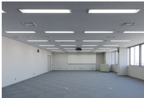
一般執務室の照明 Hf32W2灯用埋込器具調光形バッフル付と昼光利用センサーの連動で適切な明るさに照明制御
