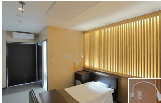
特別室1の照明 LEDダウンライトのほか、壁面に間接照明、ベッド灯には壁直付用LEDベッド灯を採用
