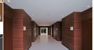
廊下の照明 LEDダウンライトを両壁面側天井に設置
