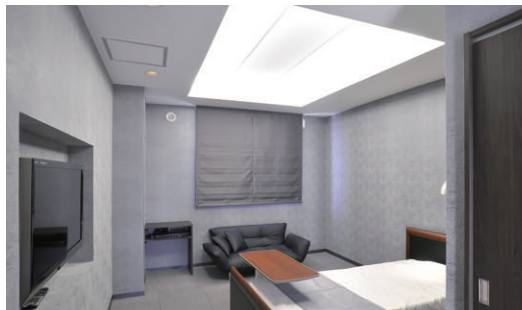
特別室2の照明 天井に間接照明とLEDダウンライト、ベッド灯はLED
