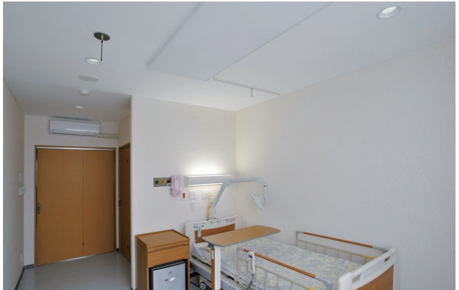
病室(1人部屋)の照明 ベース照明にはLEDダウンライトを使用し、ベッド灯にはホスピタルブラケットを採用
