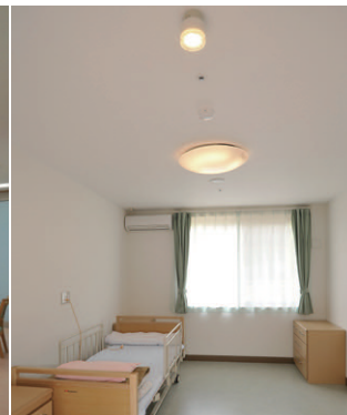
居室の照明 ベースにシーリングライトを、常夜灯にLED小形シーリングライトを採用
