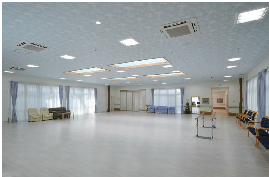
交流スペースの照明 天井のあかり取りからの自然光を損なうことのないよう昼白色のHf薄形直付スクエア器具を均等配置
