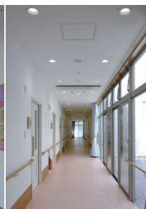
LEDダウンライトによる廊下の照明
