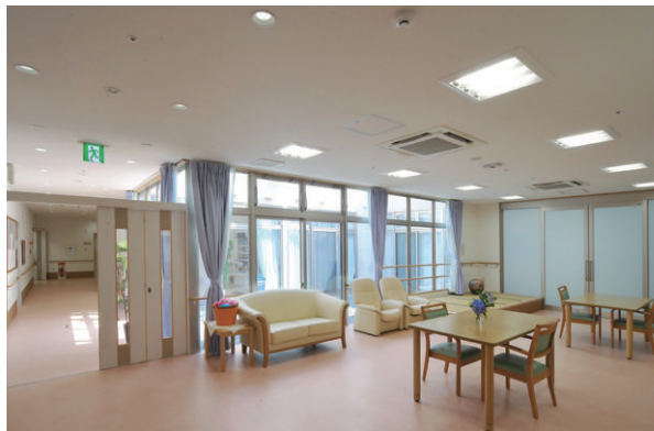
共同生活コーナーの照明 交流スペースと同様器具を採用し、連続感を創出
