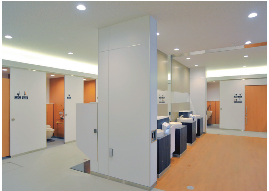
上り線男子トイレの照明 ベース照明に小電力のLEDダウンライトを採用し、壁面の建築化照明で柔らかな広がり感のあるあかりを演出
