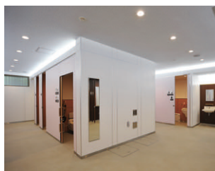
下り線女子トイレの照明
