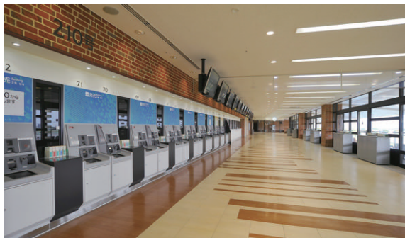
FHT42W2灯用ダウンライトによる投票所の照明 自動発売・払戻兼用窓口上部にはLEDダウンライトを設置
