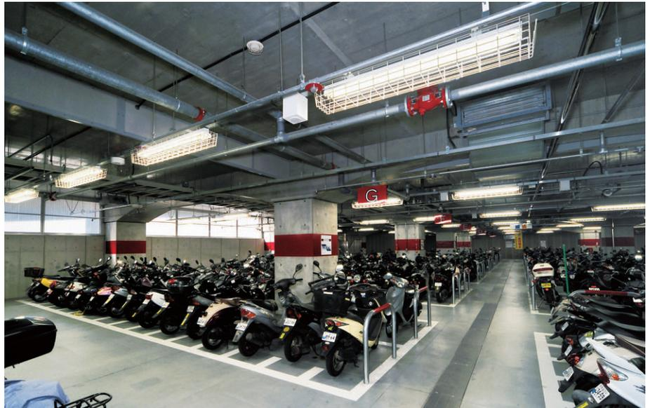
1階原付自転車駐車場 多分割した通路に沿って、通信機能付FHF32W2灯用反射笠器具を整列配置
