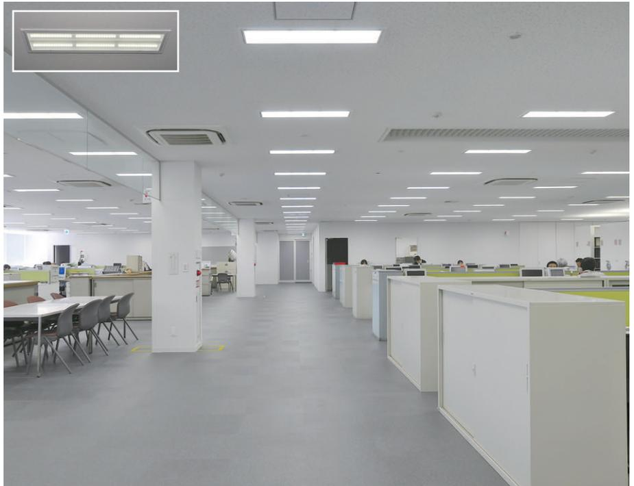
2階本事務所の照明 LEDベースライトストレートタイプ調光用を採用。机上面を明るく、適度な顔面照度も確保しながら消費電力を抑制
