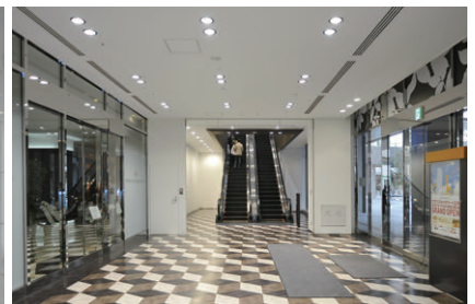
店舗エントランスホール セラミックメタルハライドランプダウンライトをサンプルに設置し、LEDダウンライトを水平照明に採用
