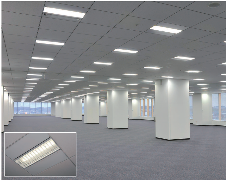
オフィスの照明 FHP45W1灯用システム天井用器具連続調光形(特注)を採用。初期照度補正と昼光利用制御により、より高い省エネ性能を実現
