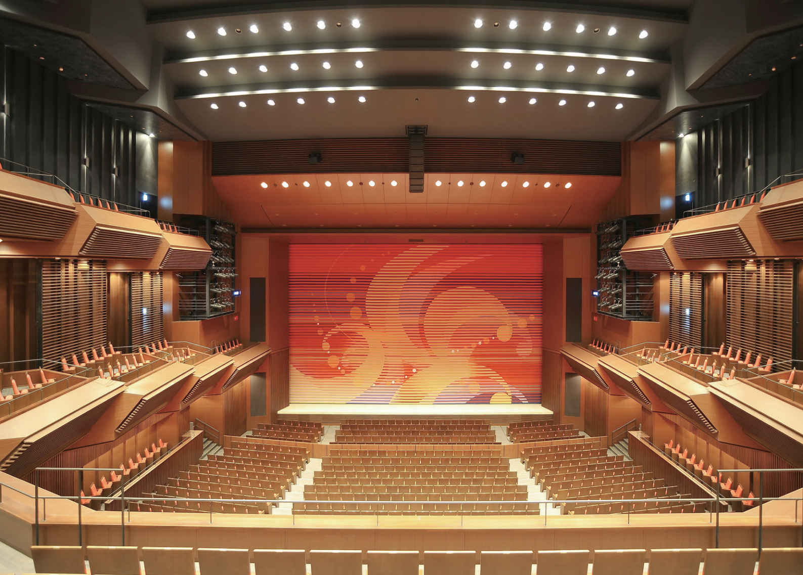
市民ホールの照明 高く抜けた天井に500Wハロゲンランプダウンライトを多用し、ダイナミックな照明を演出
