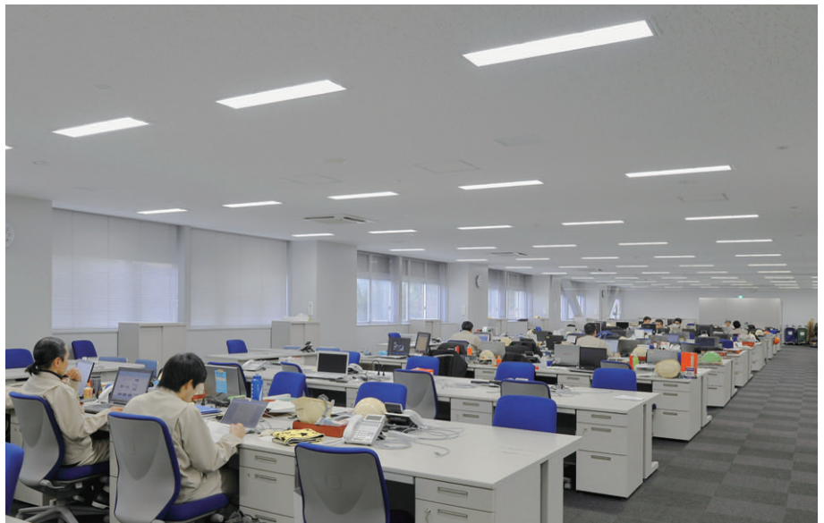
事務所の照明 省電力・長寿命のLEDベースライトストレートタイプを採用。人感センサーとの連動で人がいないときは25%に減光し、さらなる省エネを実現
