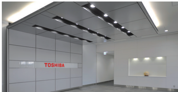
LEDダウンライトと建築化照明で器具の存在感を抑えて高質な光環境を確保したエントランスホール
