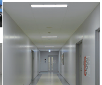
LEDベースライトと人感センサーによる廊下の照明
