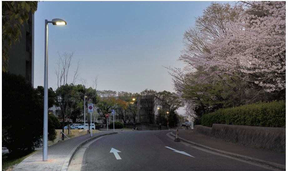
250W水銀ランプ外灯を更新した、優れた省エネ性と長寿命のLEDの外灯
