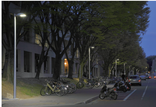
グリーンベルト周辺道路の歩道・車道用に採用されたLEDの外灯（角形）
