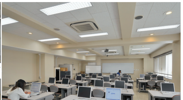
エネカット32+<プラス>3灯用ルーバー付と調光可能形LEDダウンライトによるコンピューター室の照明
