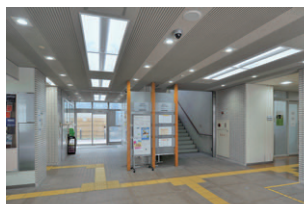
エネカット32+<プラス>とLEDダウンライトに更新した玄関・エレベーターホール
