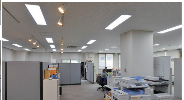
プレゼンテーションルームの照明 デジタル制御照明デジタルクス2灯用乳白カバー付とLEDスポットライトを採用
