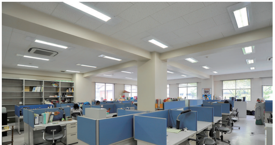
大学院研究室の照明 55WLEDベースライトストレートタイプ調光形を採用し、大幅な消費電力の削減を図るとともに、あかりセンサーとの組み合わせによる昼光利用制御でさらなる省エネを実現
