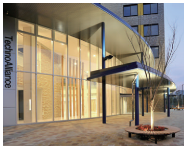
正面玄関前の外構照明
