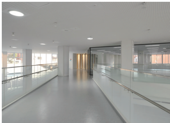
吹抜ブリッジ周りの照明
