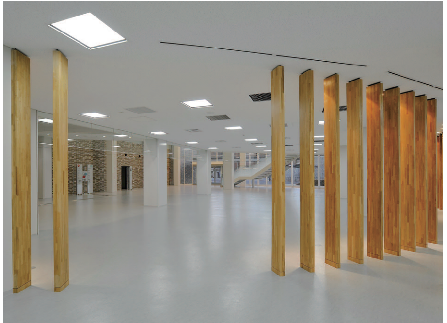
1階交流エリアの交流サロンの照明 FHP45W3灯用及び4灯用埋込器具カバー付を採用。柔らかな拡散光でゆったりと落ち着いた空間を演出
