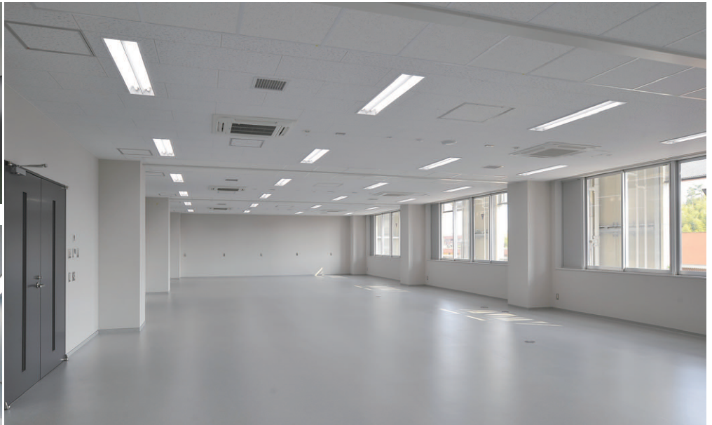
実験室の照明 Hf32W2灯用遮光角制御器具を採用し、あかりセンサーで初期照度補正と昼光利用制御により、省エネしながら適正照度を確保
