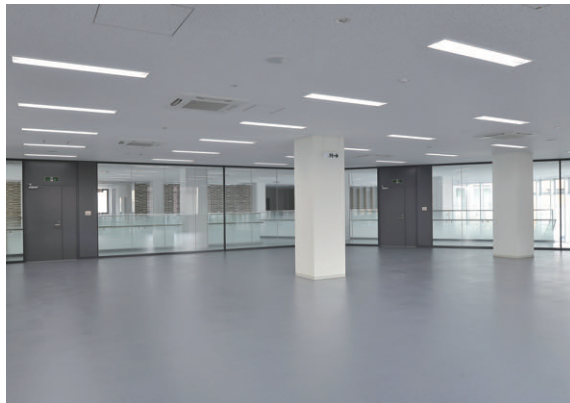
遮光角制御形器具とあかりセンサーを採用した事務室の照明
