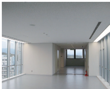
3階から9階にある交流ロビーには窓際に建築化照明を配置
