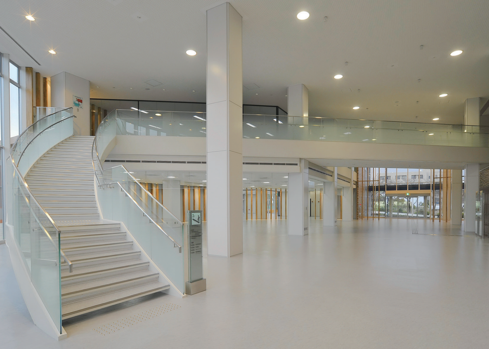
交流エリアのアライアンスホールの照明 吹抜天井に250Wネオセラダウンライト電動昇降装置付を採用し均等配置。多目的機能に対応しながら、メンテナンスにも配慮
