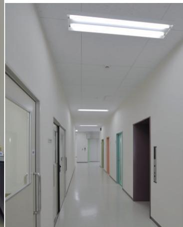
Hf蛍光灯器具と人感センサーによる自動ON/OFF制御を行っている廊下の照明
