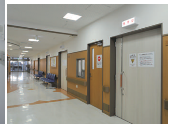
検査部門の廊下の照明
