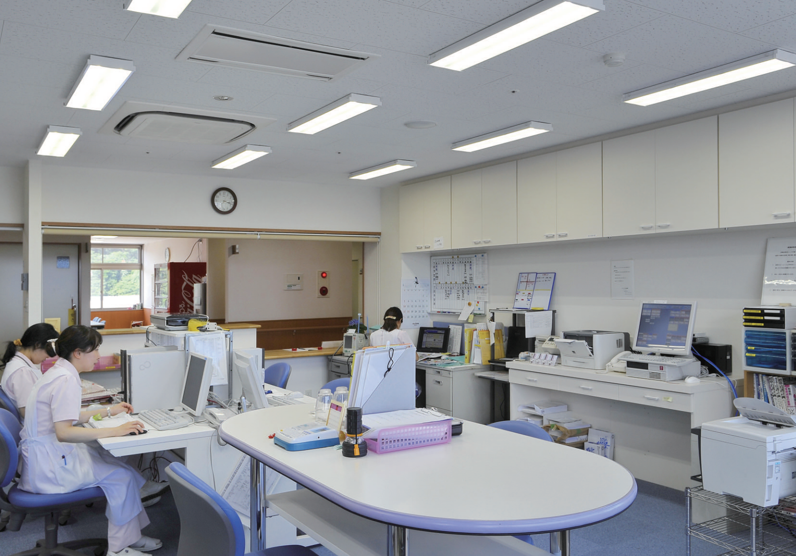
ナースステーションの照明 LEDベースライトストレートタイプ直付形を採用し、昼白色の光色で明るさを高めています
