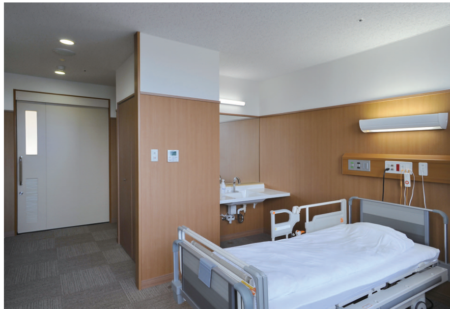
病室の照明 ベースライトに電球形蛍光灯ダウンライトを採用し、ベッド灯には間接照明・読書灯・常夜灯一体形のホスピタルブラケットを配置
