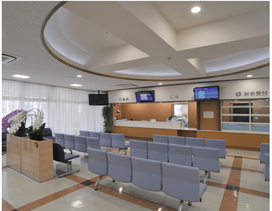
総合受付・待合室の照明 円形の折り上げ天井内にLEDライン器具を配置した間接照明とその周囲に蛍光灯ダウンライトとスクエア器具を採用
