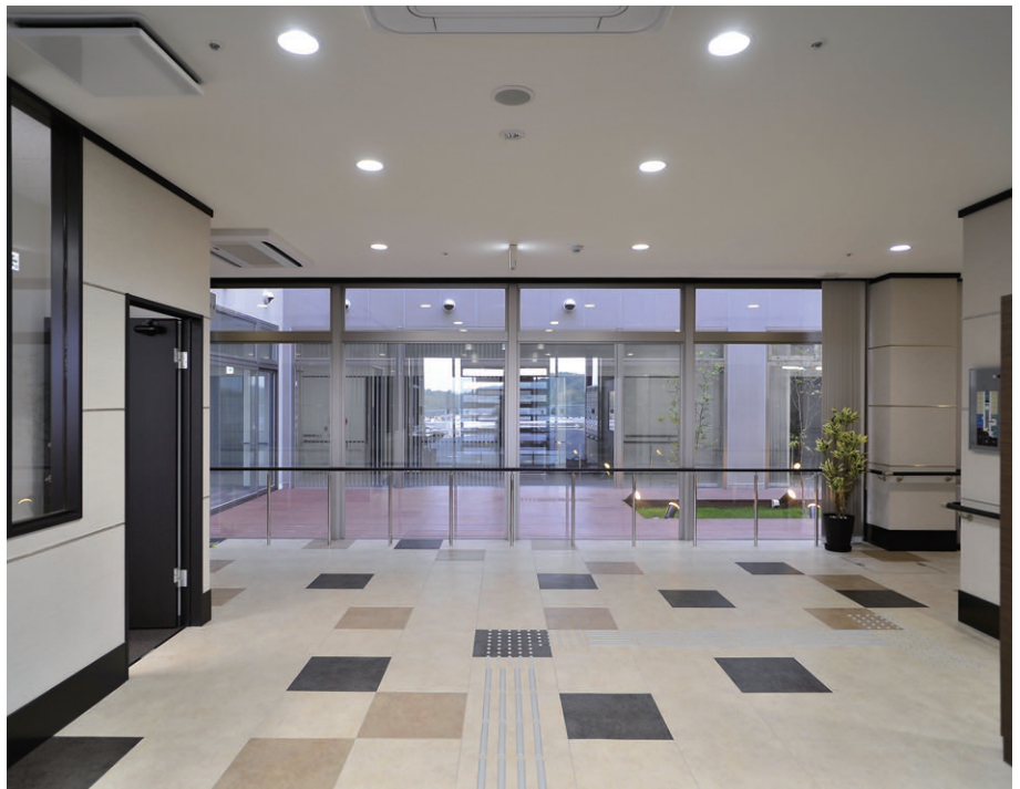
エントランスホールの照明 LED電球付属のダウンライト昼白色を採用し、省エネしながら明るい空間を演出
