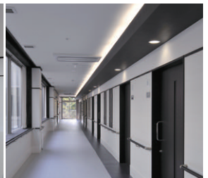
ダウンライトと間接照明で眩しさを抑制した廊下の照明
