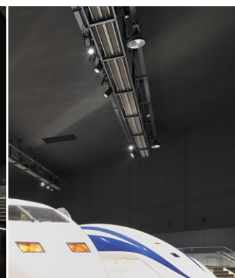
キャットウォークに設けた照明パトンにLEDスポットライトを設置
