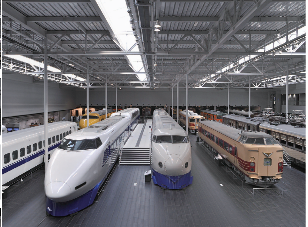
2階見学デッキから正面を望む車両展示照明状況。高天井用器具はキャットウォーク下部の照明バトンに設置
