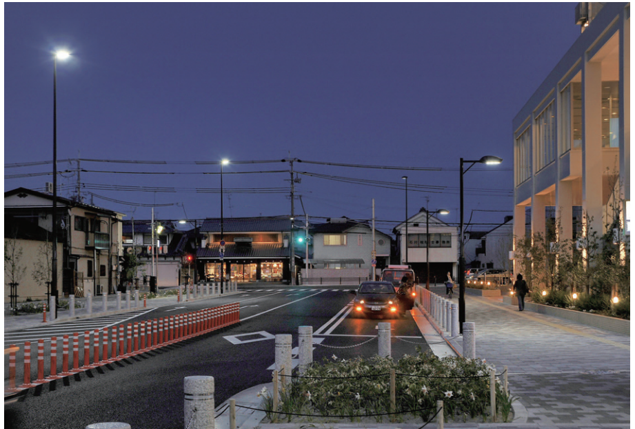
車道照明にはLED灯具を高さ10mの照明柱に配備し、千鳥配列。歩道照明はLED灯具を高さ5mの照明柱に配備
