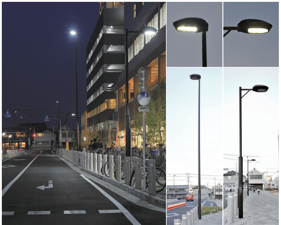
LED道路灯は約35m間隔の千鳥配置。LED歩道灯は片側約70mの車道
