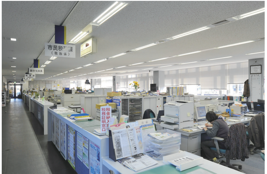
1階窓口・執務室の照明 システム天井用の蛍光灯器具をLEDベースライトストレートタイプ調光形に更新
