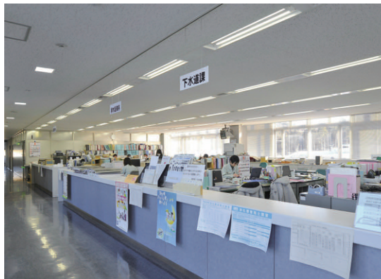
LEDベースライトストレートタイプに更新された2階窓口・執務室の照明
