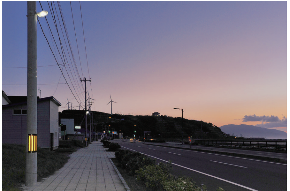
留萌海岸通りに設置されたLED街路灯。電柱の地上5mの位置に設置
