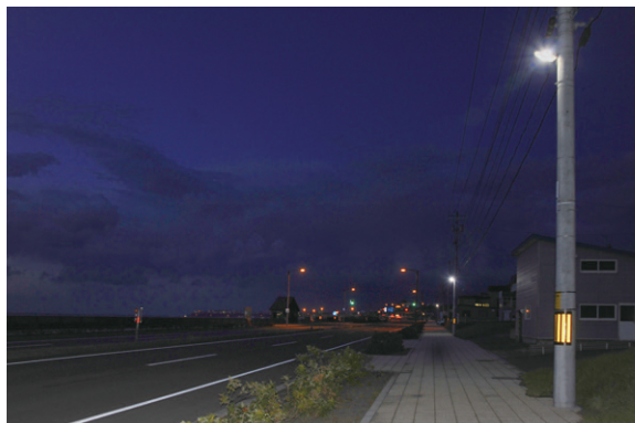
更新のLED街路灯は、100W形水銀灯と同等の明るさを18.3Wの消費電力で実現
