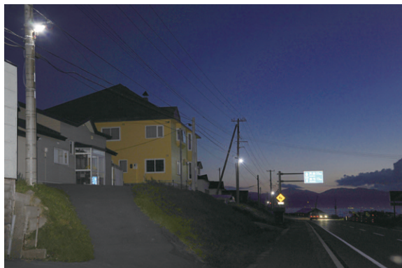
生活道路用には電柱の地上4.5mの位置にLED街路灯を設置
