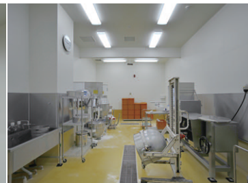
乳白カバー付蛍光灯器具を採用した調査室の照明
