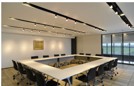
2階多目的ルームに採用されたライティングレール用ハロゲンランプスポットライト
