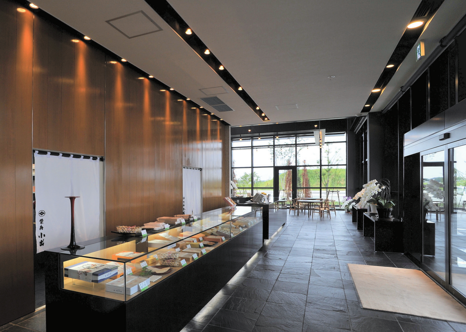
入口部にはハロゲンランプダウンライトにより外光との光バランスを配慮し、商品ケース上部と壁面間接照明はLEDダウンライトを採用
