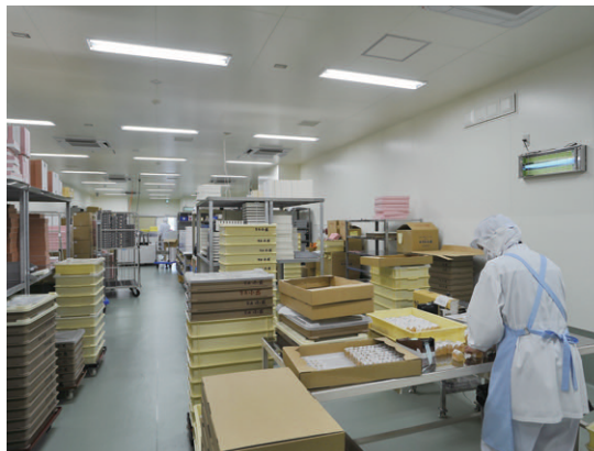
蛍光灯薄形直付器具を採用した1階包装室の照明
