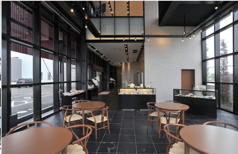
店舗奥の売場・休憩スペースの照明 化粧トラスのライティングレール用ハロゲンランプスポットライトで下方空間と上部壁面を照明
