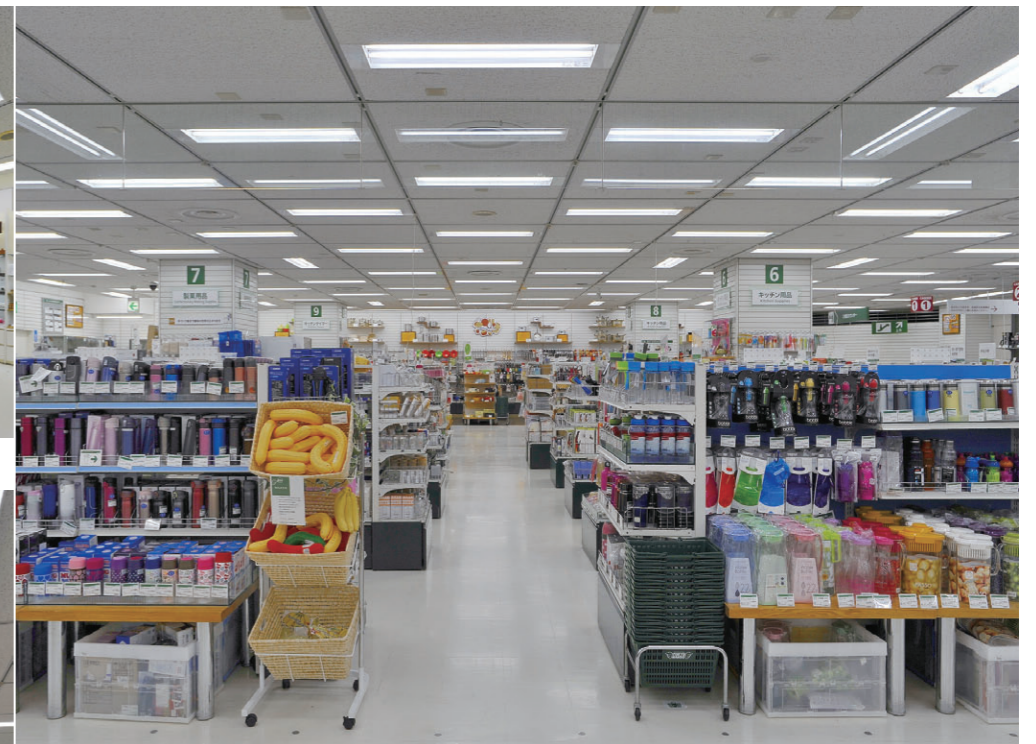
4階キッチン・バス・トイレタリー売場の直管形LEDベースライトによる照明
