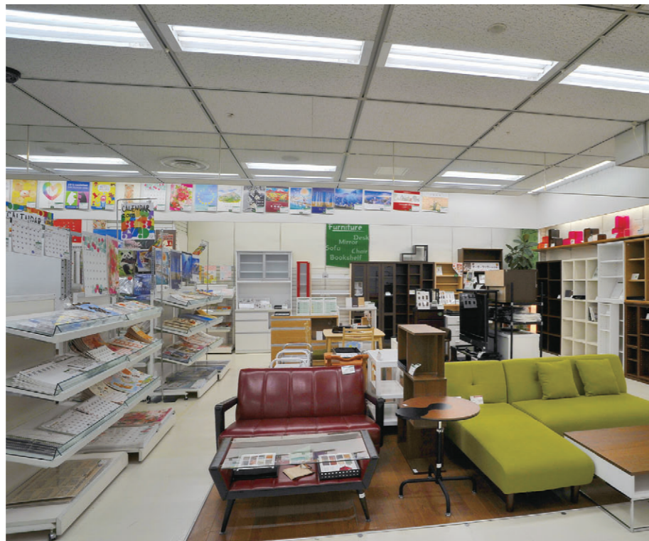
直管形LEDベースライト埋込器具に更新された5階インテリア売場
