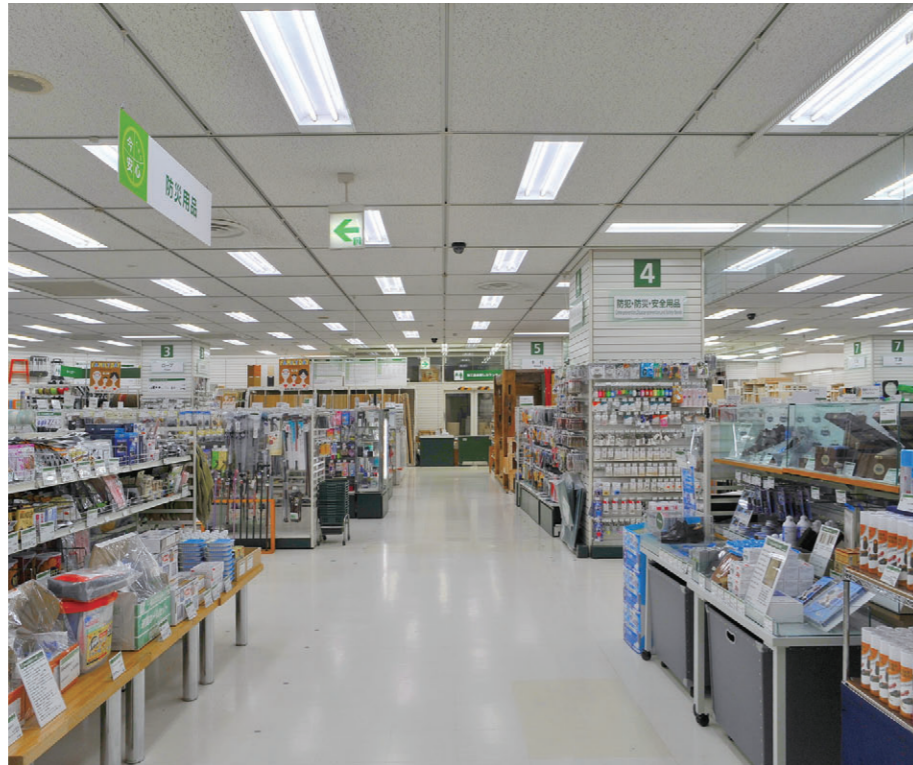
6階DIYツール&マテリアル売場の照明 FLR40W2灯用埋込器具から40形2灯用直管形LEDベースライト埋込器具に更新
