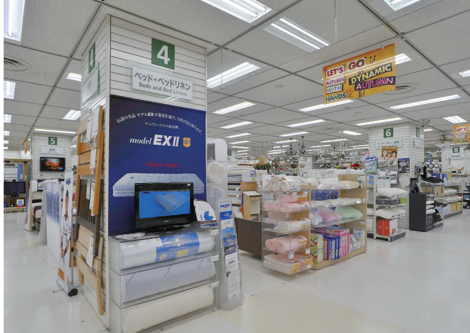
直管形LEDベースライト埋込器具による5階ベッド・ベッドリネン売場周辺の照明
