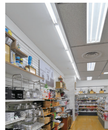
直管形LEDベースライトトラフ器具による壁面展示商品の照明
