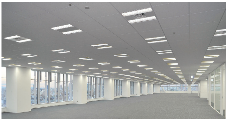
基準階オフィスフロアに採用されたシステム天井用LED照明
