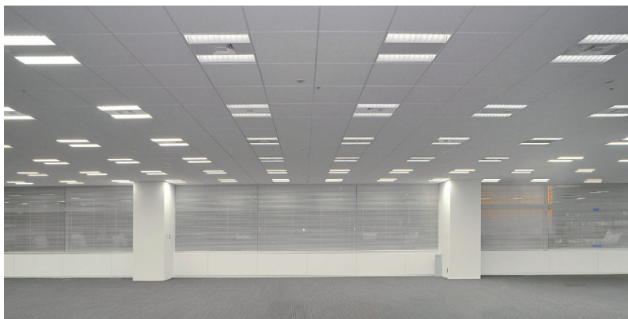
オフィス内部ゾーンから外周ゾーンを望むシステム天井用LED照明が設置されたオフィス空間
