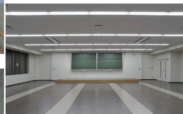
Hf埋込器具+あかりセンサーによる講義室の照明
