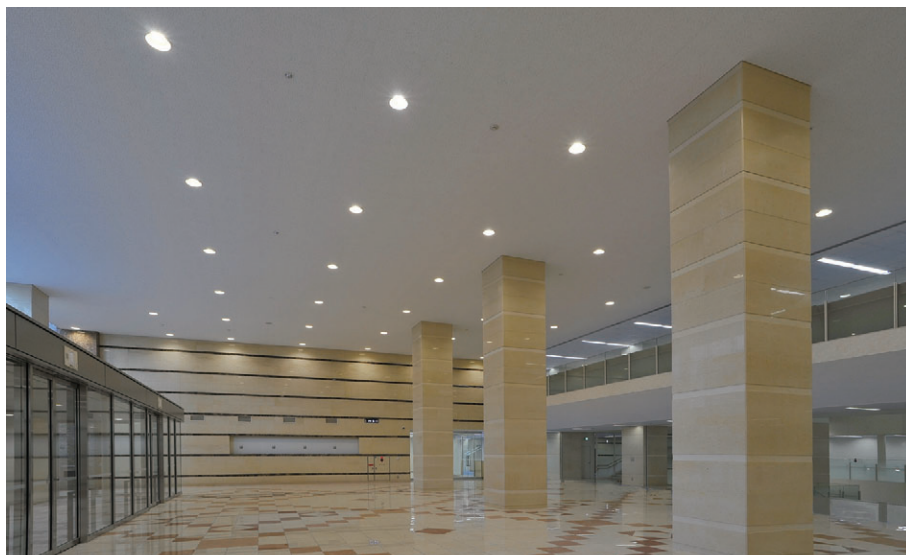
1階エントランス LEDダウンライト6000シリーズ高出力・高演色タイプを採用し、下面拡散カバーを設置
