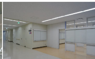
廊下および自習室のHfシステム器具
