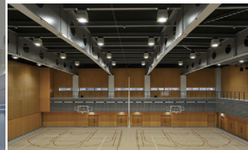
300W+400Wネオセラバンクライトによる体育施設の照明
