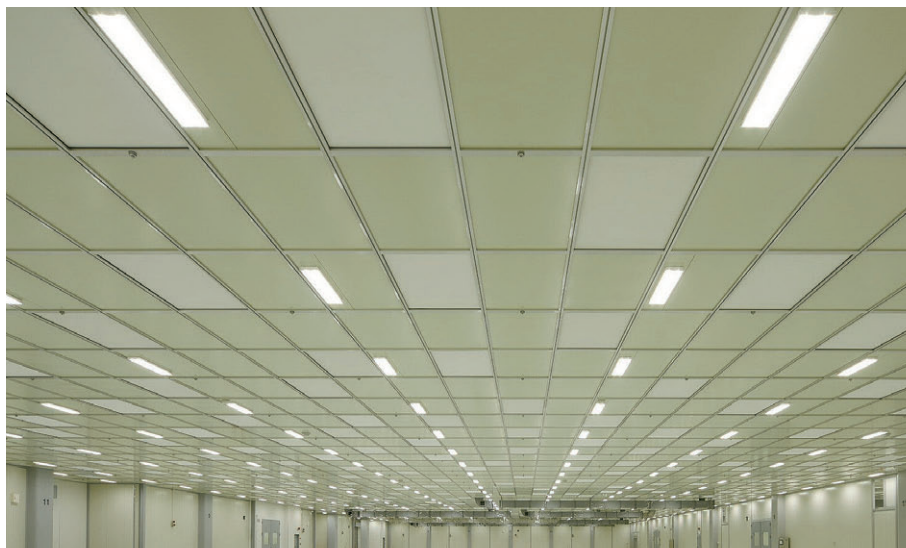
クリーンルームメインフロアには白色光の一体形LEDベースライト直付形ストレートタイプを採用
